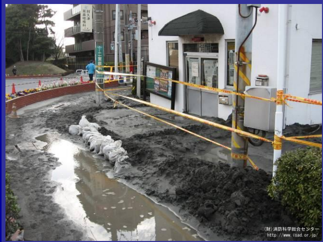
液状化による被害 (千葉県浦安市)
