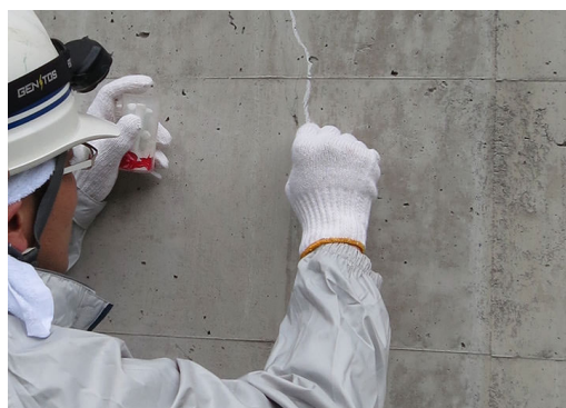
図3 近接目視点検
