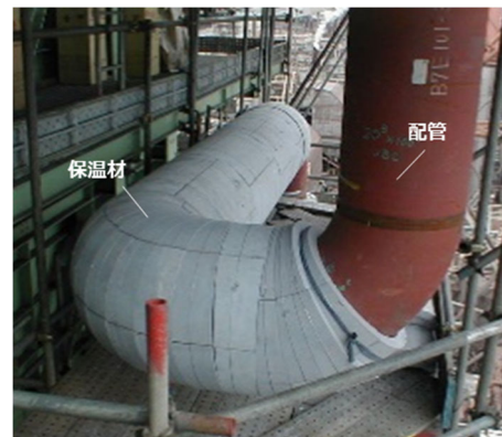
保温材取付け (施工中)
